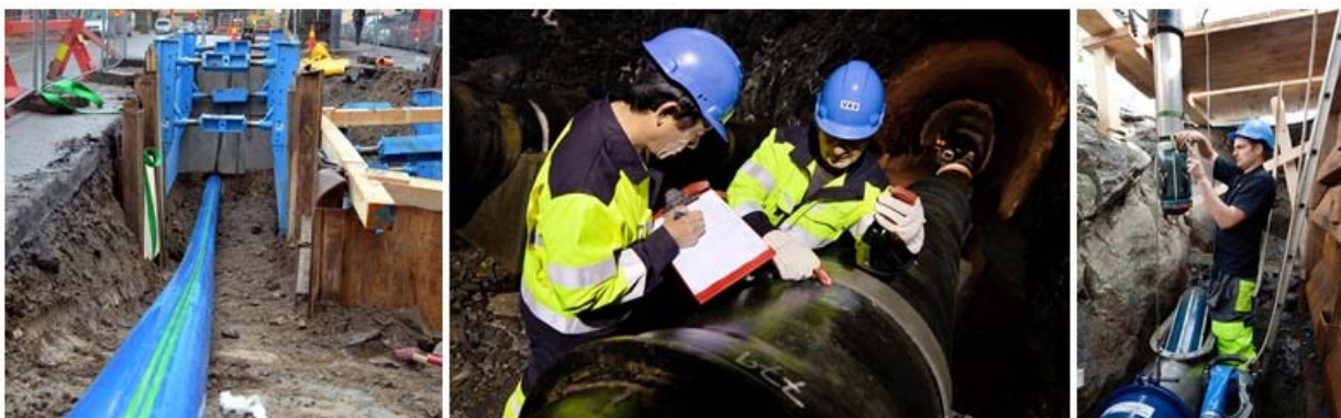
Ledningsarbeid. Foto: Vann- og avløpsetaten
